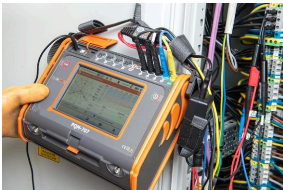
L'APQM-707 pendant l'analyse d'une installation photovoltaïque
