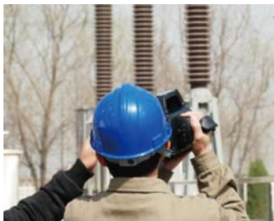
Inspection d'un poste électrique avec l'installation en service
