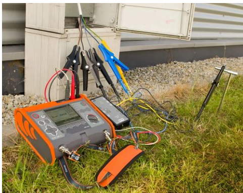
Mesure de résistance de terre avec l'AMPI-525 sur le terrain
