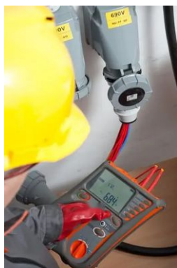
Mesure de boucle sur une prise industrielle 690 V avec l'AMZC-305
