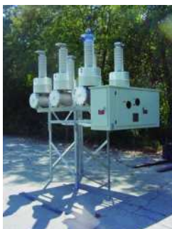
Intervention sur site sur disjoncteurs individuels
