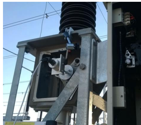
Capteur rotatif numérique monté sur un disjoncteur ABB LTB 245 kV SF6
