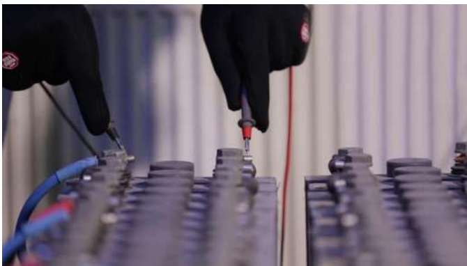
Prova di capacità su un banco di batterie stazionarie
