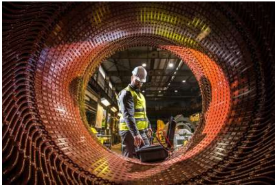
Prova di isolamento sullo statore di una grande macchina elettrica
