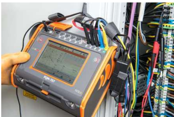
L'APQM-707 durante l'analisi di un impianto fotovoltaico
