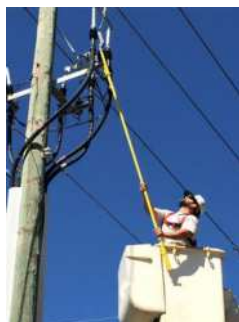
Controllo di un accessorio di linea aerea con asta isolante
