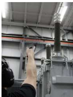
Ispezione con il sensore parabolico esterno in una sottostazione
