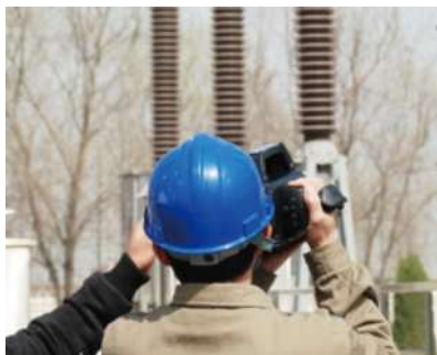
Ispezione di sottostazione con l'impianto in servizio
