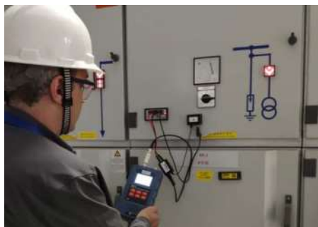
Medida de descargas parciales en un centro de transformación
