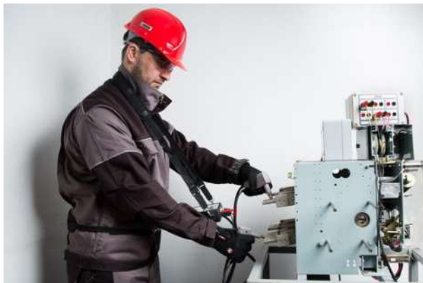
Medida de resistencia de contactos sobre un interruptor en la subestación
