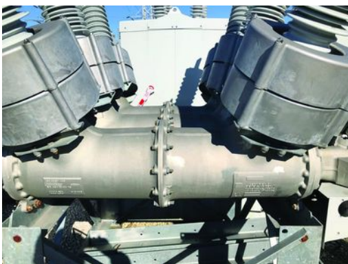
Mecanismo de operación e interruptor de alta tensión, con el sistema de energía almacenada supervisado por el BPM.
