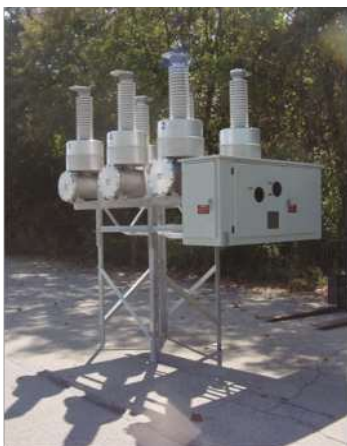
INTERRUPTOR - 72,5kV: Peso de SF 6 : 29 lbs – 13 Kg
