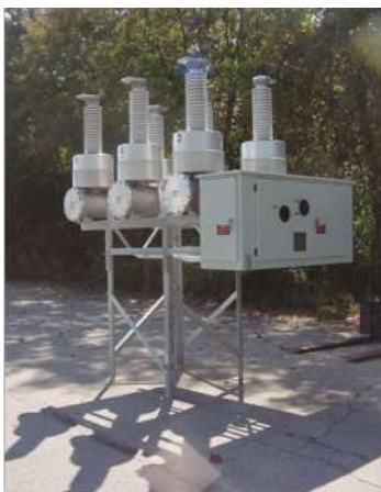
INTERRUPTOR - 72,5kV: Peso de SF 6 : 29 lbs - 13 Kg
