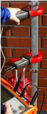
Método de doble pinza: resistencia de tierra sin desconectar la instalación
