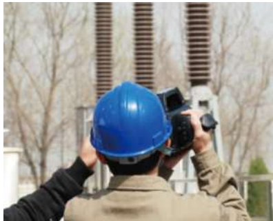
Inspeção de uma subestação com a instalação em serviço
