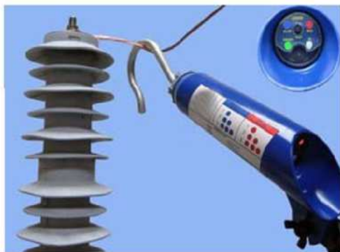
Verificação de um pára-raios com o PADD numa linha energizada
