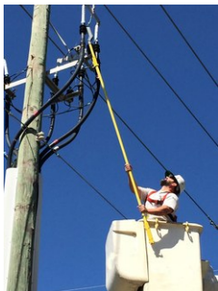
Verificação de um acessório de linha aérea com vara isolante
