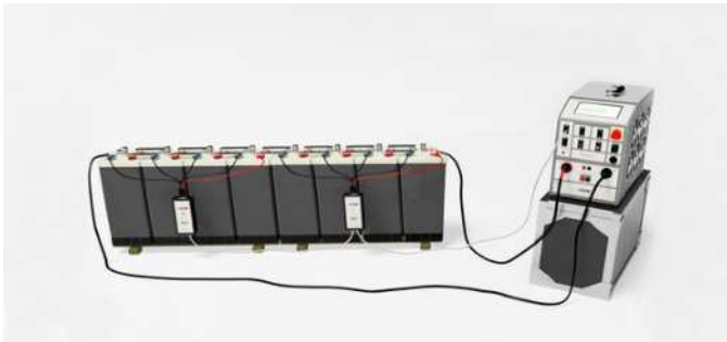
Sistema completo a supervisionar um banco durante o ensaio de descarga
