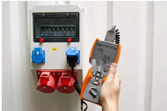
Medição de malha num quadro industrial com o AMZC-304
