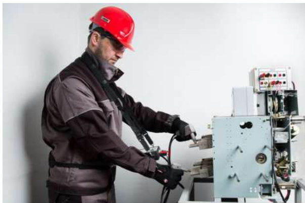
Ensaio de um disjuntor na subestação com o circuito auxiliar alimentado
