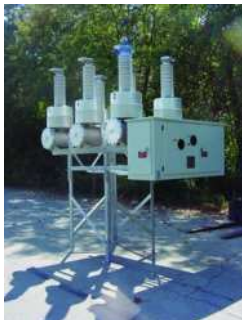
Serviço em campo em disjuntores individuais
