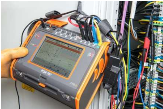
O APQM-707 durante a análise de uma instalação fotovoltaica
